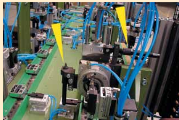
Geoptimaliseerde productie in de elektronische industrie
